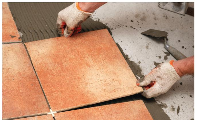
用瓷砖胶粘贴面砖在安装好的板面。
