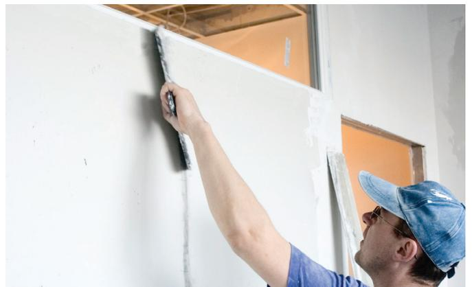
用填缝料处理隔墙。
