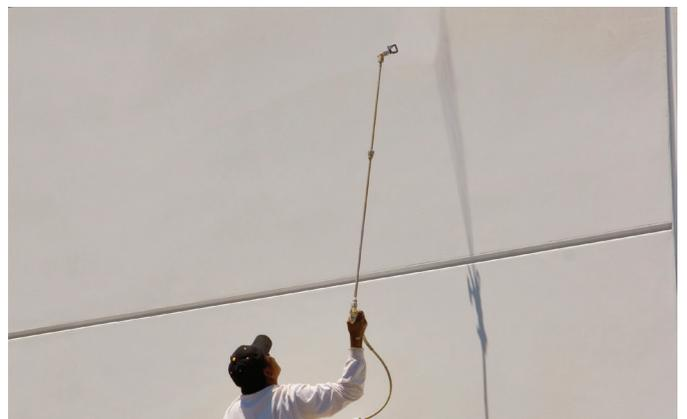
水基或油基涂料均适合喷涂在安装好的板面。
